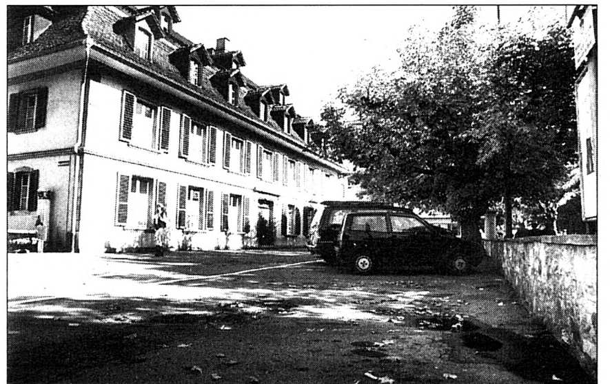
Die markante Mauer entlang des Waisenhausplatzes (rechts) soll zwar erhalten, aber durchlässiger gestaltet werden. (Bild: Bruno Stüdle)
