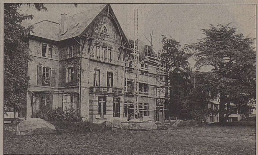
Le bâtiment principal de la Fondation Silo fait l'objet d'importants travaux.
