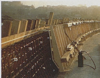
L'époxy, pour combattre la rouille
